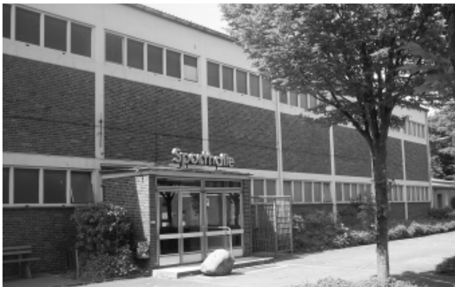
Sporthalle an der Ochtruper Straße
